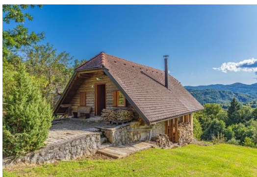
Slika 8: Zidanica Derganc na Drganjih Selih. Vir: Booking.com (14. 4. 2023).
